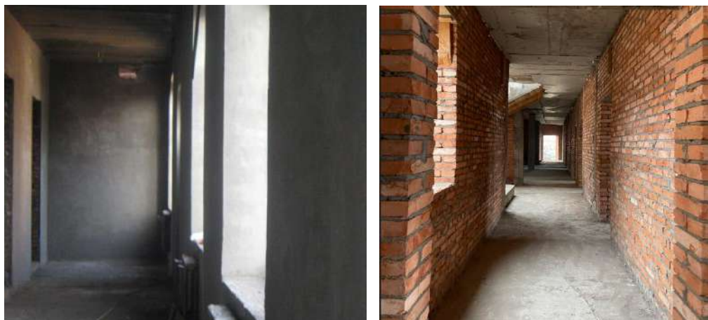
Рисунок 14 – Применение штукатурных и кладочных растворов на мелких песках, модифицированных КМД, на строительных объектах
