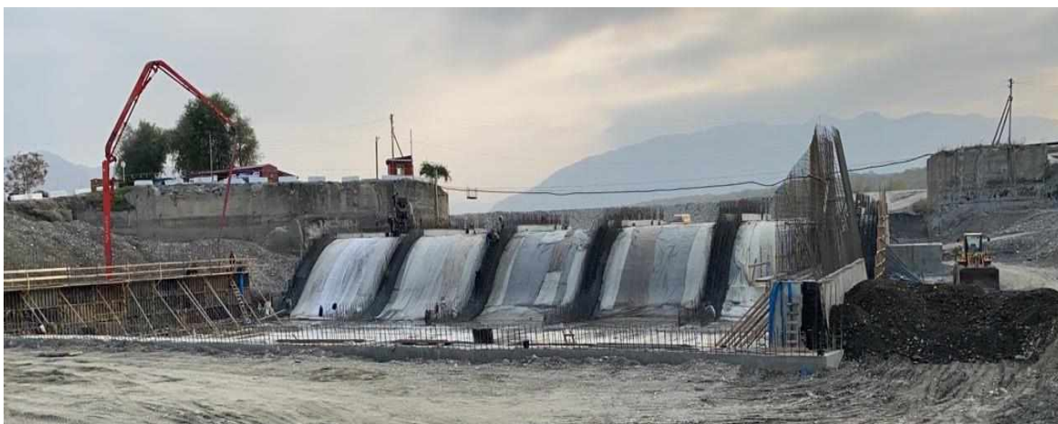
Рисунок 8.7 – Объект внедрения ВКБ класса В60 «Реконструкция Аргунского гидроузла (с.Чири-Юрт)» при устройстве монолитной конструкции водораспределительного узла предприятием ООО «Водстрой»
