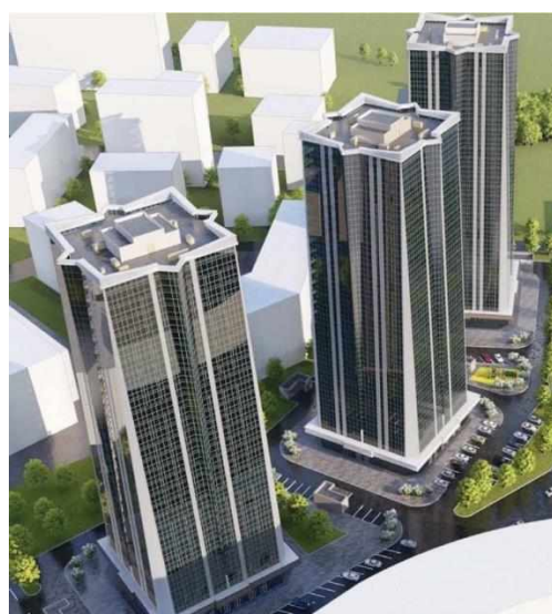
Рисунок 8.8 – Строительство жилого комплекса «Grozny Towers», где внедрены составы полифункциональных строительных композитов гидратационного твердения, получаемых на основе комплексного использования техногенного сырья
