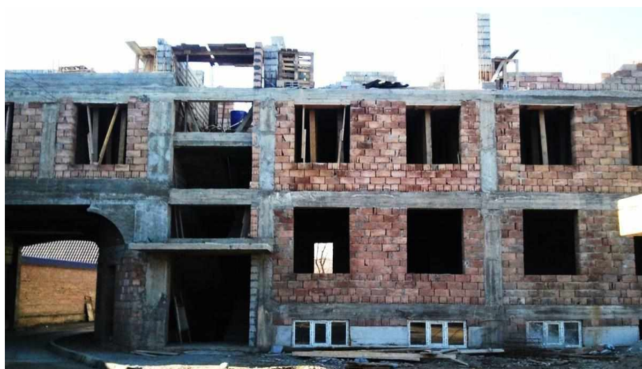
Рисунок 8.3 – Процесс возведения жилого дома
