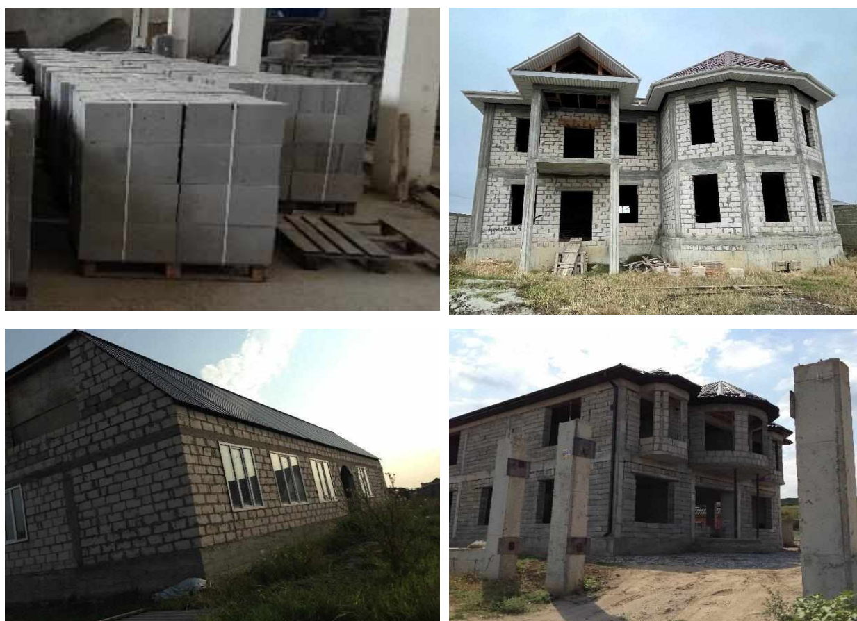
Рисунок 8.4 – Построенные коттеджи с использованием мелкоштучных строительных изделий на основе КГВ и золошлаковых смесей
