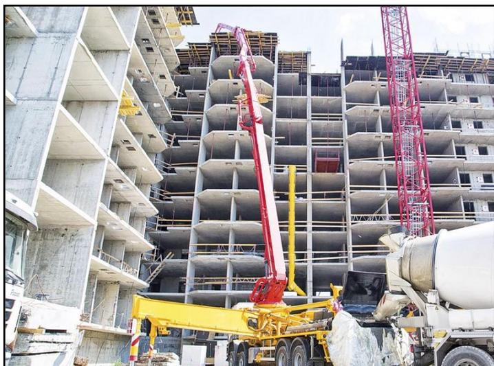
*Рисунок – Использование бетононасоса на стройке*
