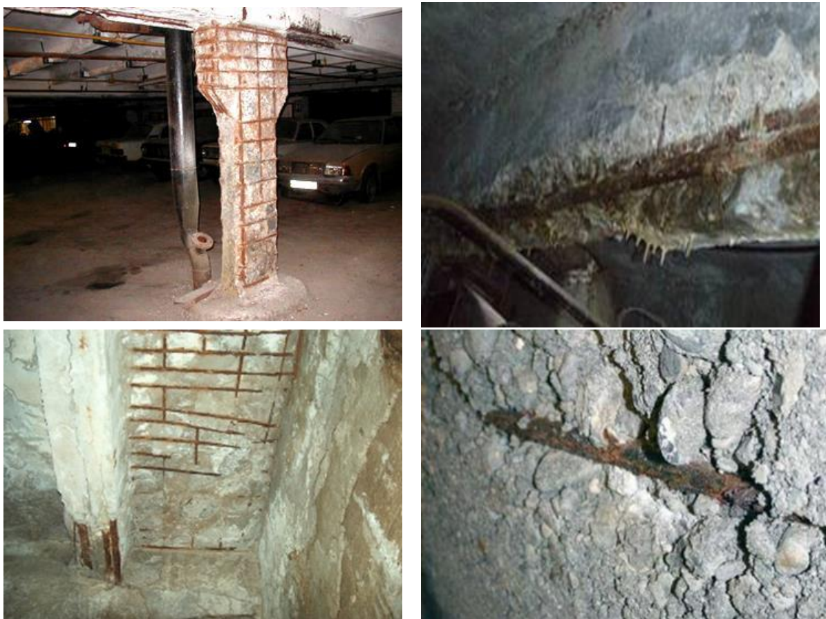
Рисунок 1.4 – Виды разрушения железобетонных элементов
