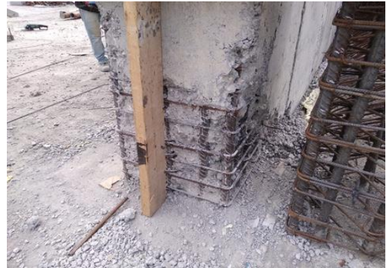
Рисунок 4.2 – Характерные виды дефектов, при проведении ремонтных работ на объектах внедрения
