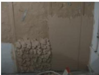
Последний, накрывочный слой, приготовленный из мелкого песка, наносят поверх грунтового слоя, тщательно выравнивая.
