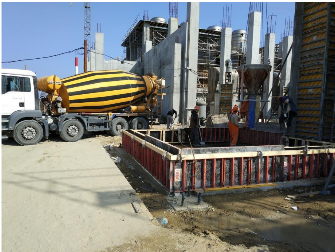
Рисунок 8 - Бетоновоз и подача бетона бадьёй.
